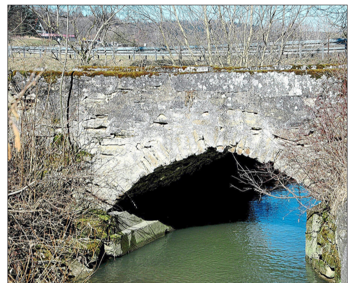
Die alte Weilheimer Brücke ist marode, kann aber nur mit hohem Aufwand saniert werden. Auch darüber wurde im Ortschaftsrat gesprochen. Foto: Ullrich
